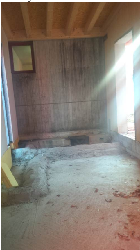
Parete in cls da demolire per nuova porta
