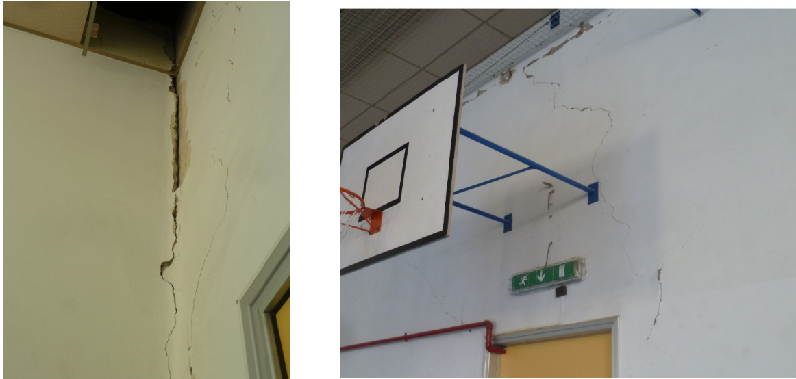
FIGURA 7 – Lesioni alle murature della palestra
