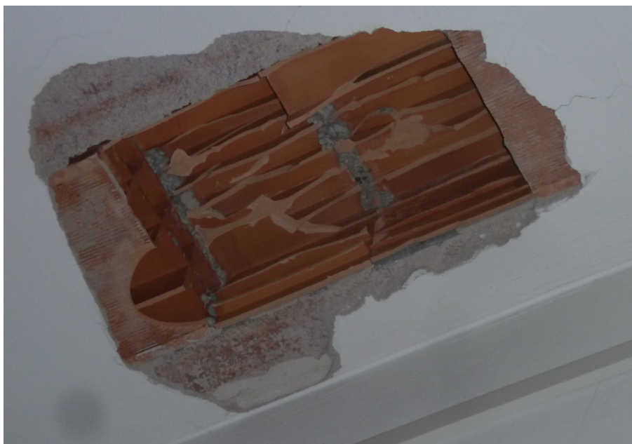
Sfondellamento solaio
