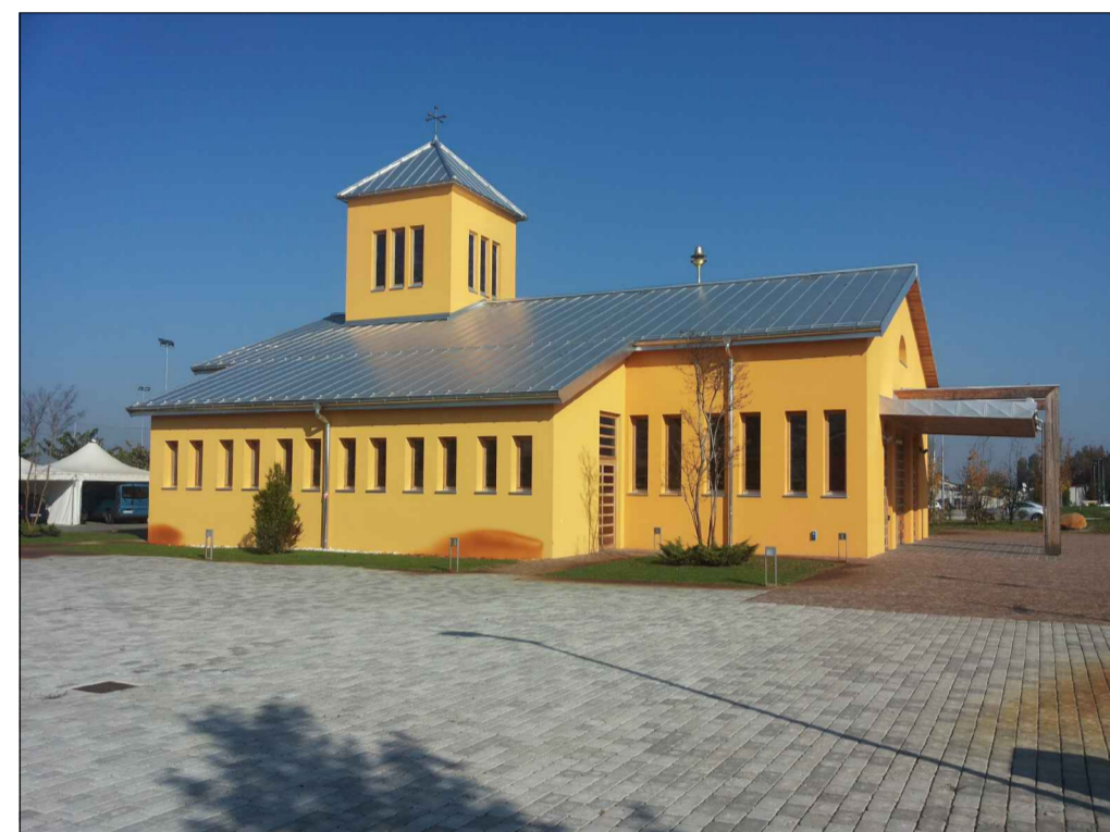
CHIESA - REALIZZATA POST SISMA 2012
