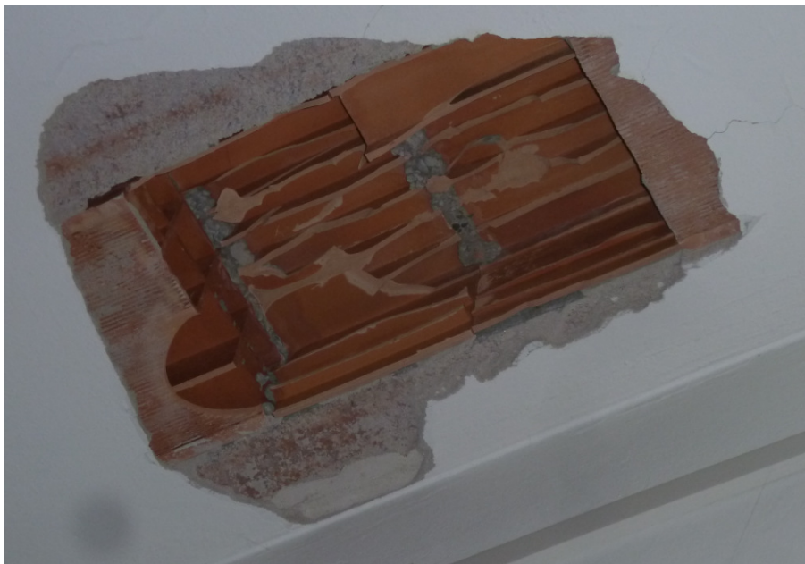
Sfondamento solaio
