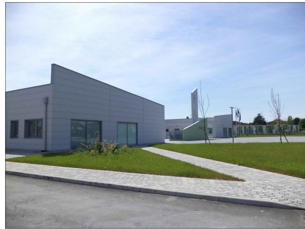
MUNICIPIO (EMT) - REALIZZATO POST SISMA 2012
